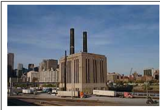
Centrale thermique de Chicago
