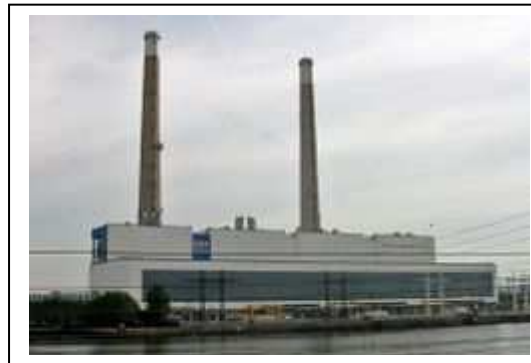
centrale thermique de Porcheville (Yveline)
